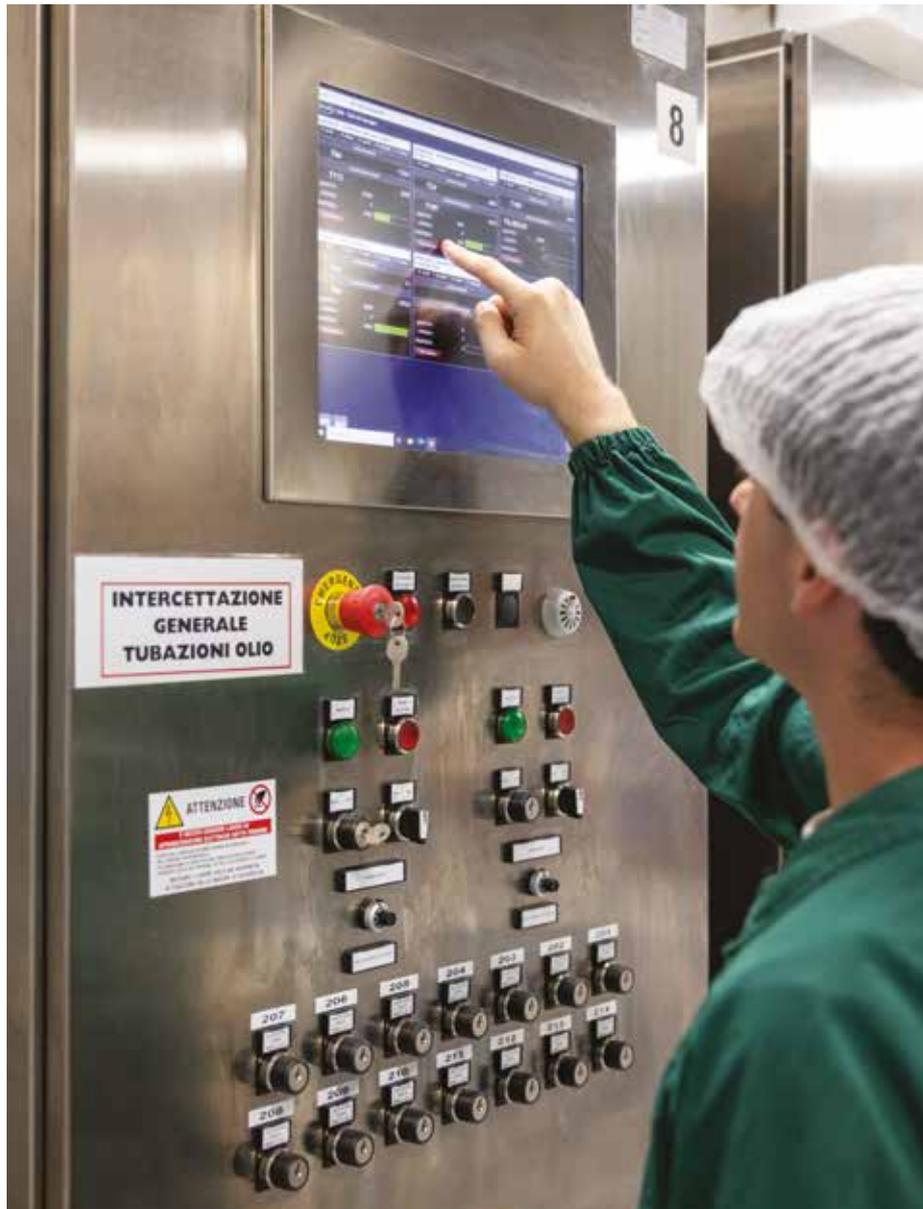
*Sistema integrato di gestione e controllo dello scarico, dello stoccaggio e della movimentazione dell'olio sfuso*
